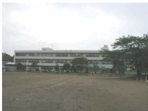
涌谷第二小学校・校舎
