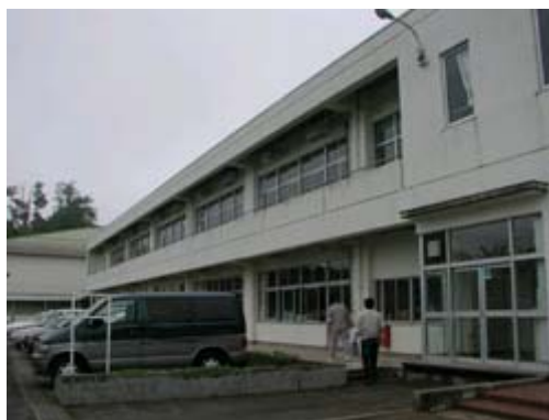
築館小学校・南棟
