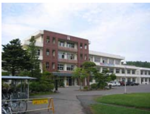
涌谷中学校・第一校舎
