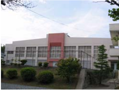
涌谷中学校・体育館 (屋根シルバークール版撤去)
