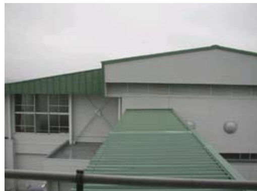
体育館・ブレース部材交換による補強
