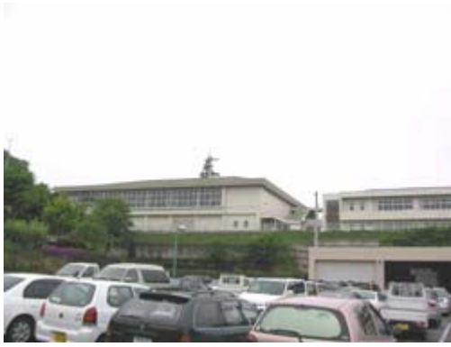
築館小学校体育館・全景
