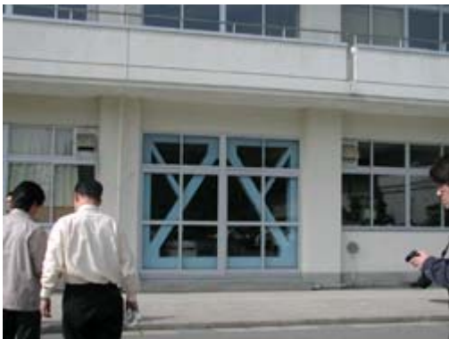
第一校舎 1F ブレース補強
