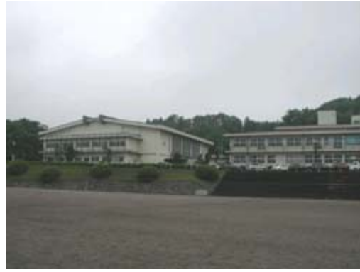
体育館全景（右手は南校舎）
