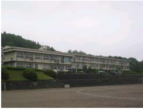
築館中学校・南校舎
