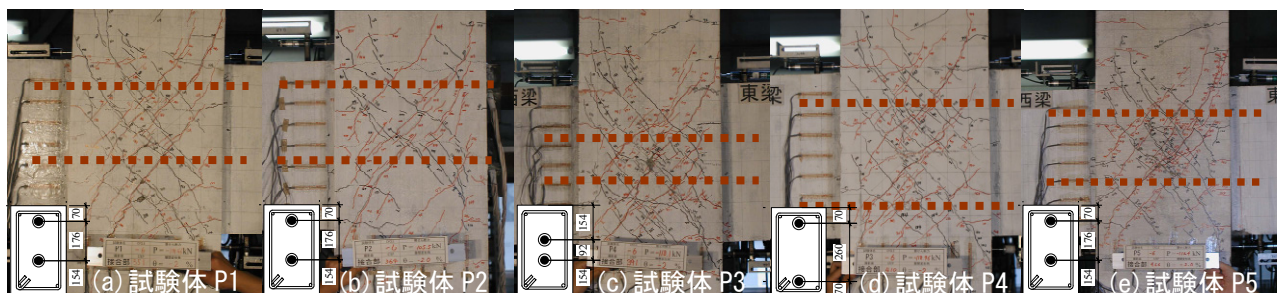
写真-3 ひび割れ状況（最大耐力時 R=2.0%時）注）点線は主筋の位置を示す。
