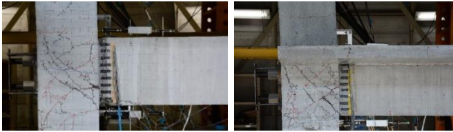
写真 1 PCJ16 (R=3.0%) のひび割れ状況
