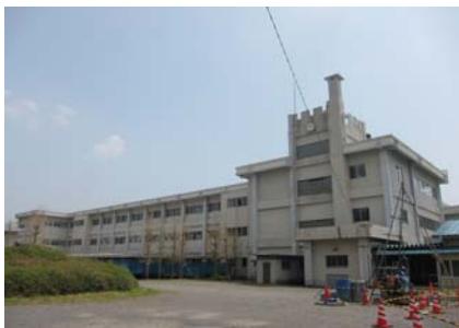
写真1 普通教室棟の北側全景
